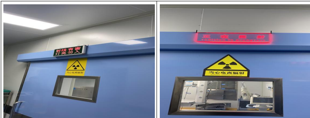
电离辐射标识铅门 (DSA1 机房)
