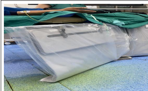
床下铅帘 (DSA1 机房)
